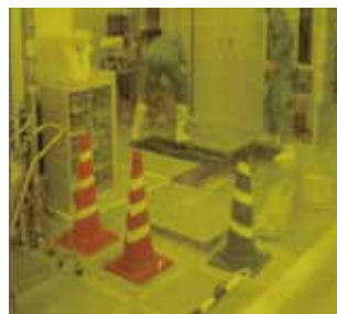
クリーンルーム施工ノウハウ
